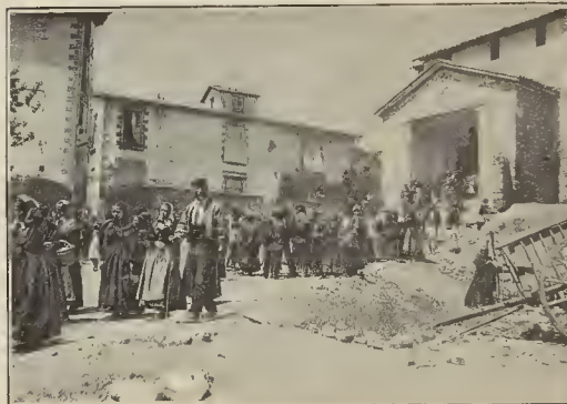
IGLESIA DE SAN PEDRO. (Vista tomada de lado.)
